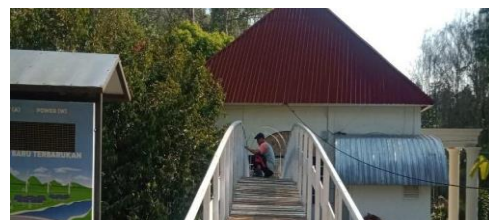
Gambar 7 . Pengecatan pada Jembatan Cinta
