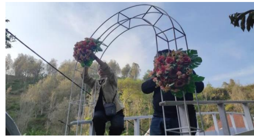
Gambar 9. Pemasangan Hiasan Pada Gapura Jembatan bagian samping
