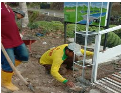
Gambar 8. Pemasangan Gapura Pada Dua Sisi Jembatan
