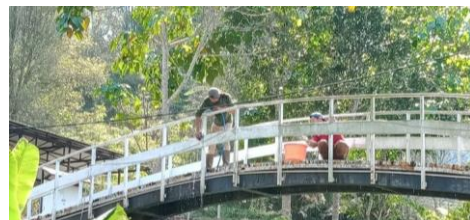
Gambar 6 . Pembersihan Jembatan dari Lumut
