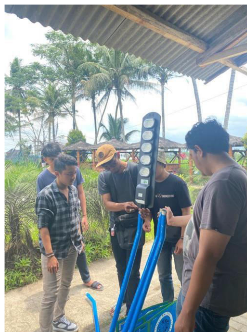
Gambar 8 Proses Pemasangan Lampu
