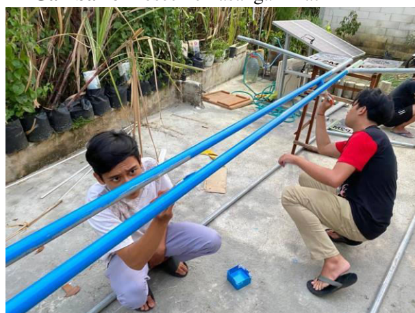
Gambar 7 Proses Pengecatan Tiang
