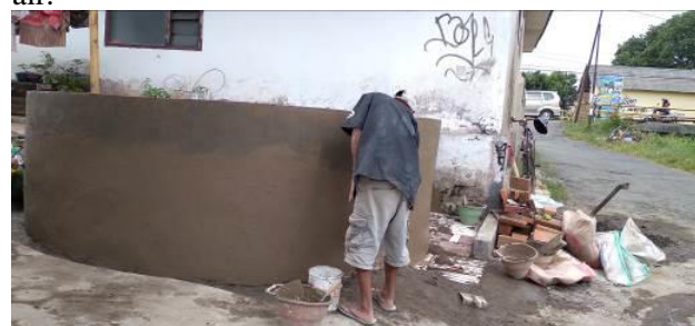
Gambar 1. Pembuatan Tandon
