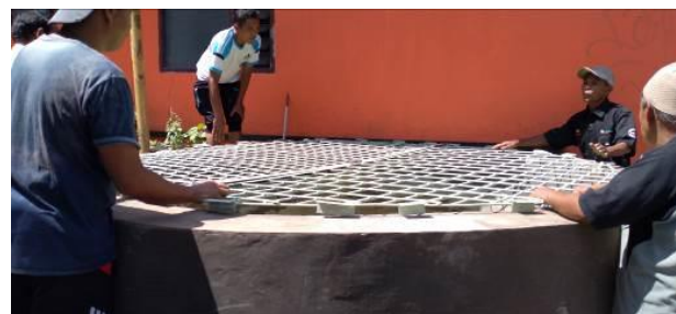
Gambar 2. Pemasangan Penutup tandon
