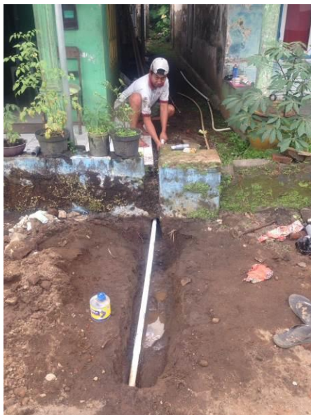
Gambar 4. Pemasangan Pipa ke rumah warga
