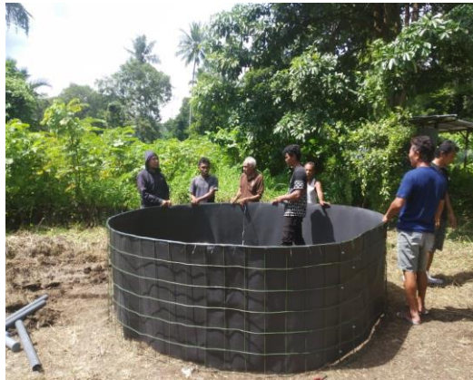
Gambar 1. Pemasangan Kolam Bundar
