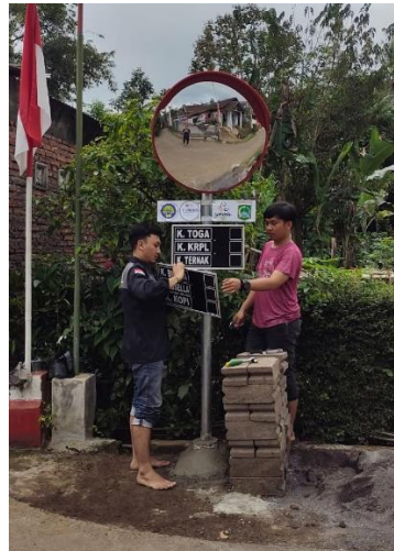
Gambar 3. Hasil Perakitan Sygnage System dengan Dilengkapi Cermin Cembung
