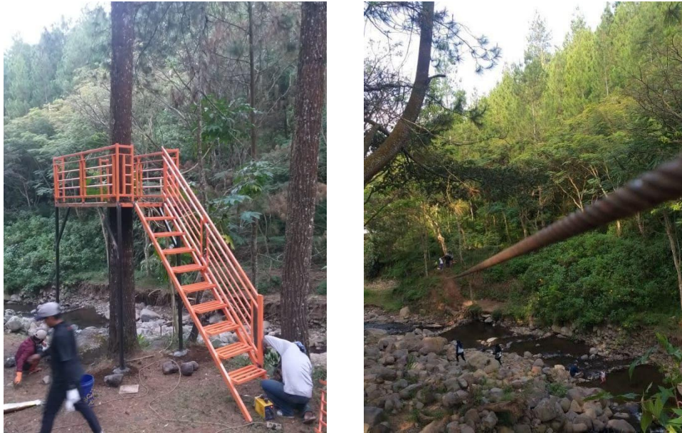
Gambar 3. Konstruksi flying fox yang lengkap terpasang
