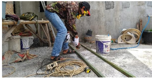
Gambar 3. Pemotongan Besi dengan APD (Bengkel Nasional) Sumber: Dokumentasi TIM Pengabdian
