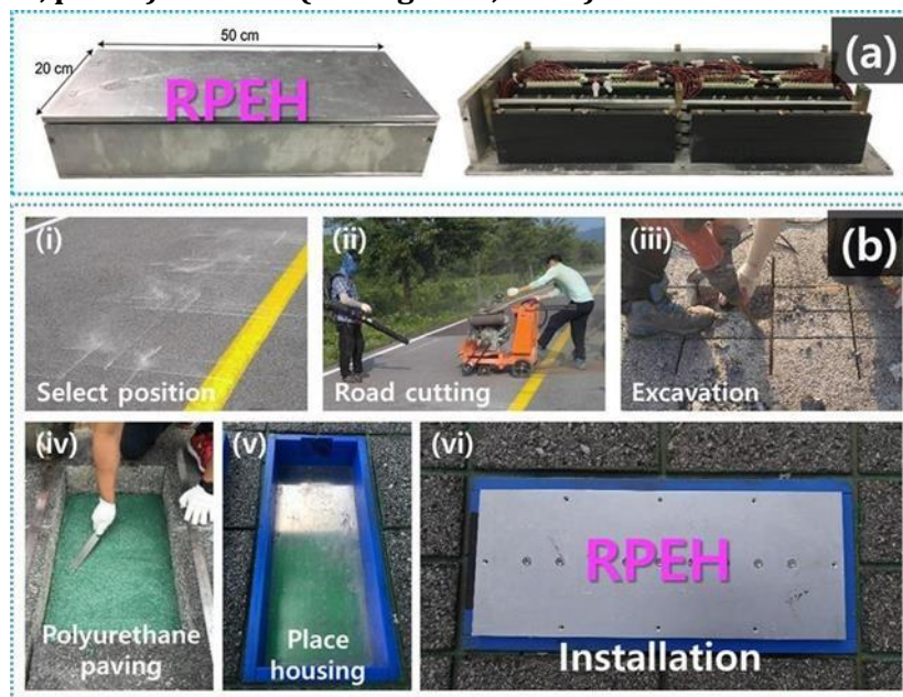
Gambar 5. (a) Foto-foto RPEH yang dipasang pada jalan uji yang sebenarnya. (b) Proses pemasangan RPEH di sepanjang jalan yang sebenarnya: (i) pemilihan posisi, (ii)
