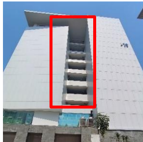
Gambar 4.67 Ventilasi alami bukaan sisi barat
