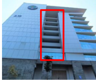
Gambar 4.16 Ventilasi alami bukaan sisi timur
