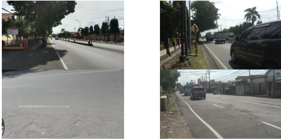
Gambar 5 Kondisi Jalan Titik Rawan Kecelakaan ( Blackspot )
