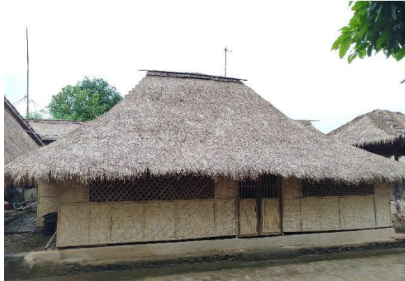
Gambar 1. Kondisi Eksisting Rumah Sasak di Ende Lombok
